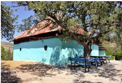
Kaygusuz Abdal Türbesi Dış Görünüm
