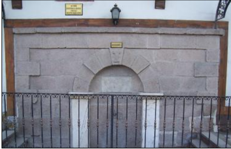
Şekil 10 Sülüm 1 çeşmesinin onarımında kullanılan derz dolgusu ve restorasyon sonrası genel görünümü.
