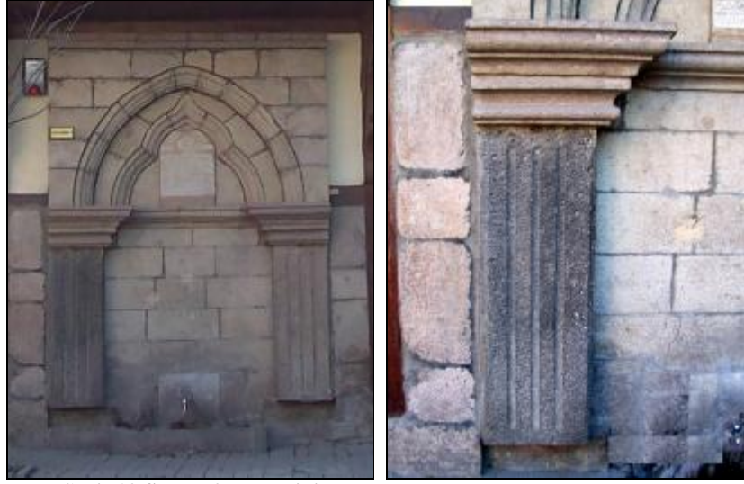
Şekil 12 Sülüm 2 çeşmesinin restorasyon sonrası genel görünümü.
