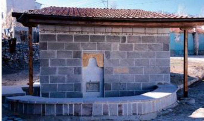
Şekil 21 Küçük Olucak çeşmesi restorasyon sonrası görünümü.
