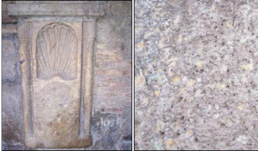
Şekil 18 Ali Ağa çeşmesi mermer sütun detayı ve restorasyon sonrası boşluklarda kalan boyalı kısımların görünümü
