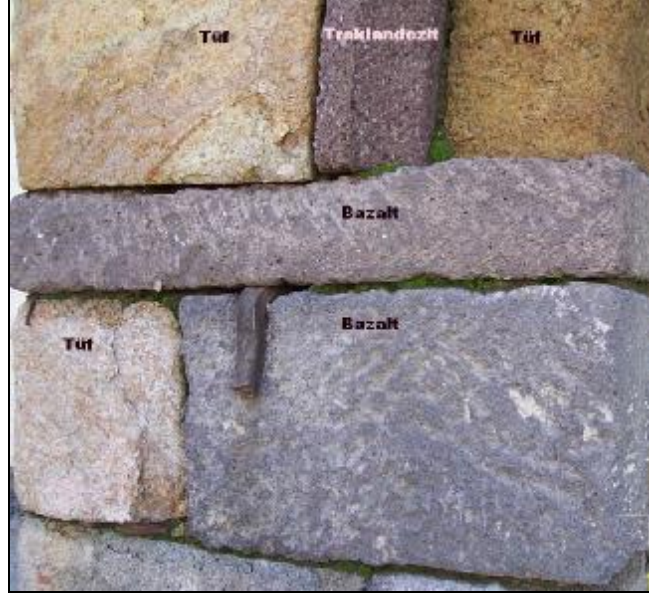
Şekil 6 Apti Kadı Çeşmesinde (Gündoğmuş Mahallesi) kullanılan bazalt, tuf ve trakiandezitler.
