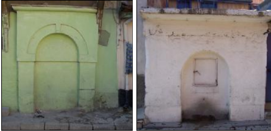
Şekil 2 Kayadibi Çeşmesi (Karamanoğlu Mahallesi), Mevlânâ Muslihüddin Çeşmesi (Orta Çeşme) (Karamanoğlu Mahallesi) nin sıvalı ve boyalı halinin görünümüleri.
