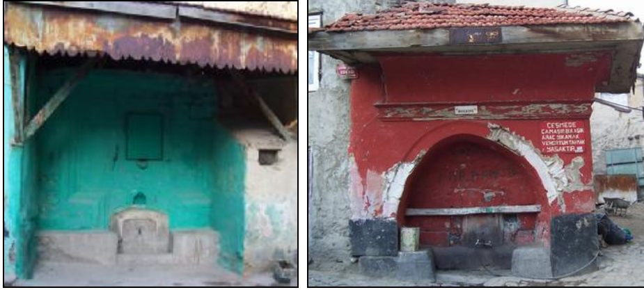
Şekil 3 Burmalı Mahallesi Çeşmesi ve Başçeşme Çeşmesi (Efecik Mahallesi)'nin sıvalı ve boyalı halinin görünümleri.
