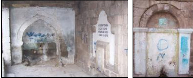
Şekil 4 Arapmescit Mahallesi Çeşmesi ve Hacı Nasuh Çeşmelerinin bir kısımlarının sıvanmış ve boyanmış durumlarının görünümü.
