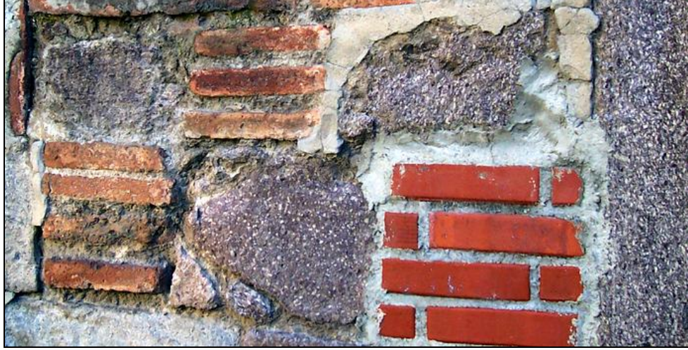
Şekil 14 Restorasyon sırasında eriyen tuğlalar yerine kullanılan ateş tuğlaları.
