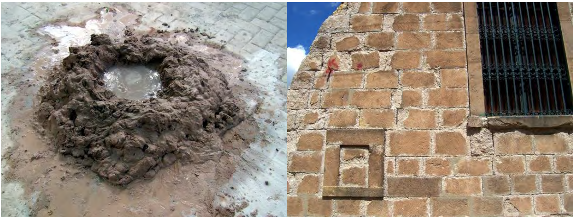
Şekil 7: Derz dolgusu ve bütünlemede kullanılan harçlar ve derz dolgularını görünümü. (The view of joint filler used in the grouting process)
