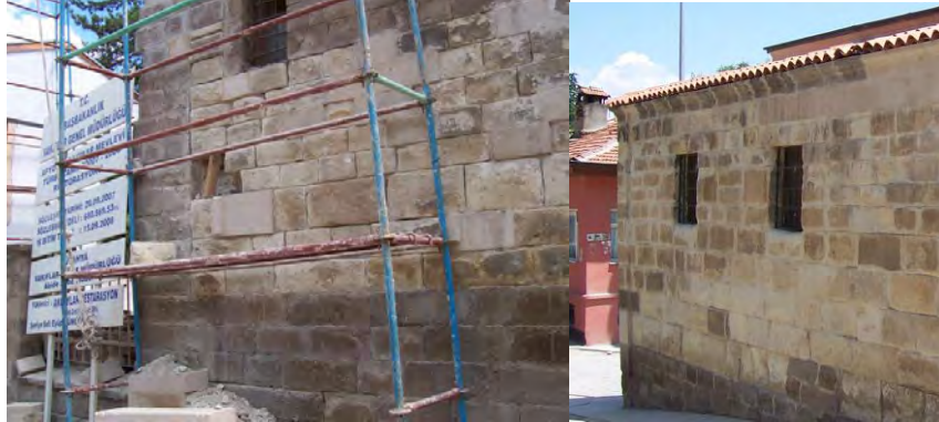
Şekil 3. Mevlevi (Türbe) Camii restorasyon çalışmasında bozmuş taşların yenilenmesinin görünümü. (Restoration of degraded stones in Mevlevi (Turbe) Mosque)
