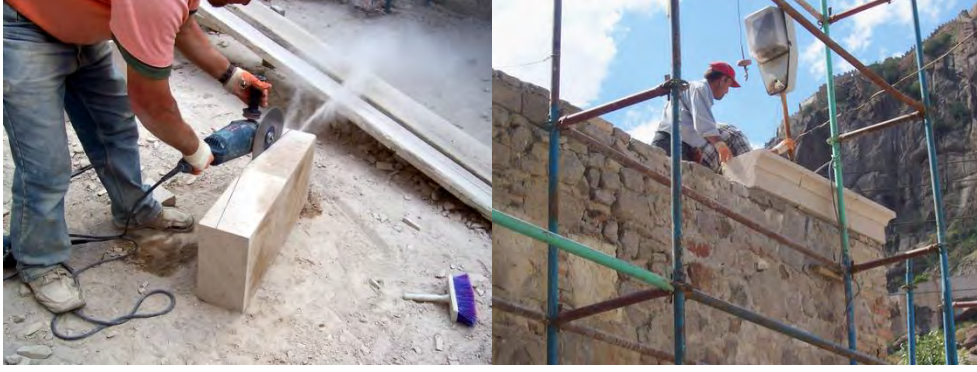
Şekil 5. Mevlevi (Türbe) Cami restorasyonunda bozmuş harpuştaların yenilenmesinin görünümü (Restoration of capstones in Mevlevi (Turbe) Mosque).
