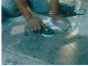
Şekil 4. Honlanmış mermer yüzeyinde oluşan lekelerin silinmesi.
