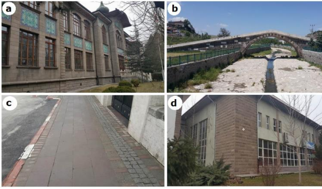
Şekil. 1. Afyonkarahisar yöresinde andezitlerin yapı taşı olarak kullanımına örnekler. Afyon Lisesi (a), İncehisar Köprüsü (b), kaldırım (c), Afyon Lisesi ek binası (d).
