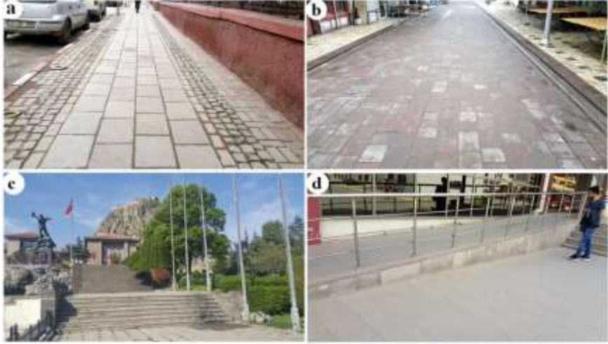
Şekil 1. Andezitin kaldırım ve yaya yollarında kaplama ve kaldırım taşı olarak kullanılması. (a: Afyonkarahisar’da bir kaldırım, b: Emirdağ’da bir yaya yolu, c: Afyonkarahisar Anıt Park merdivenleri, d: Afyon Kocatepe Üniversitesi Kampüsü)
