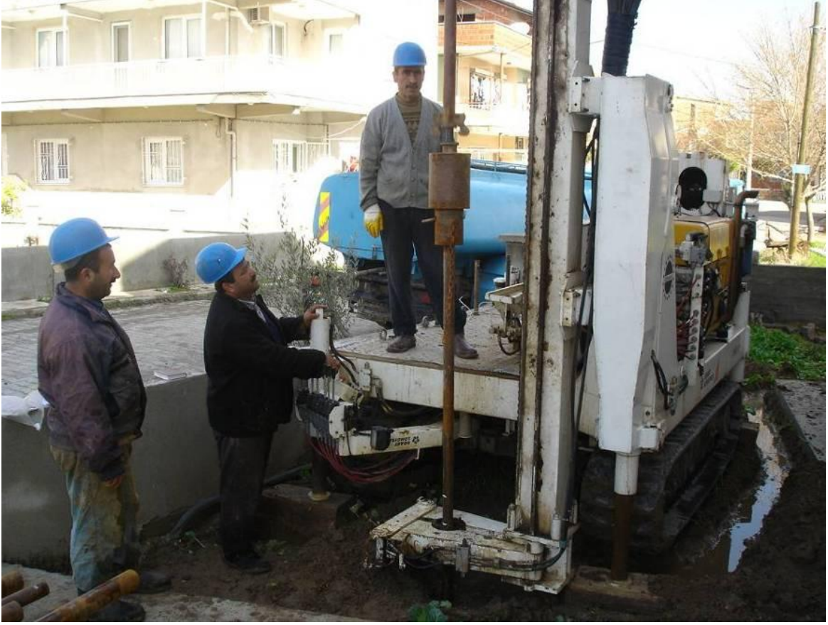
Şekil 6. Boart Long-year sondaj makinasından görünüm.
