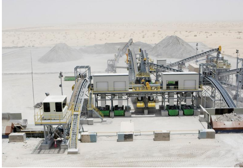
Resim 2.1 Abu Dabi'deki Al Dhafra geri dönüştürülmüş beton agregası üretim tesisi
