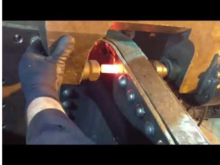
Resim 2. 1 Sıcak Perçinleme Yapılışı (İnt.Kyn.1).
