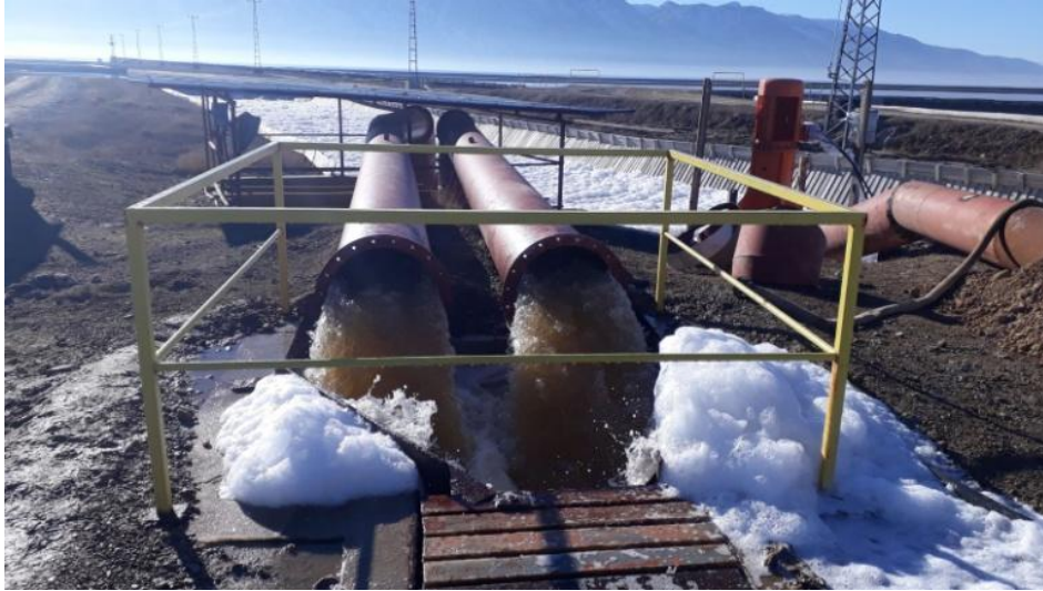
Resim 2.5 Mirabilite kristalizasyonu sonrası tuzlu üst suların sodyum klorür üretim havuzlarına alınması.
