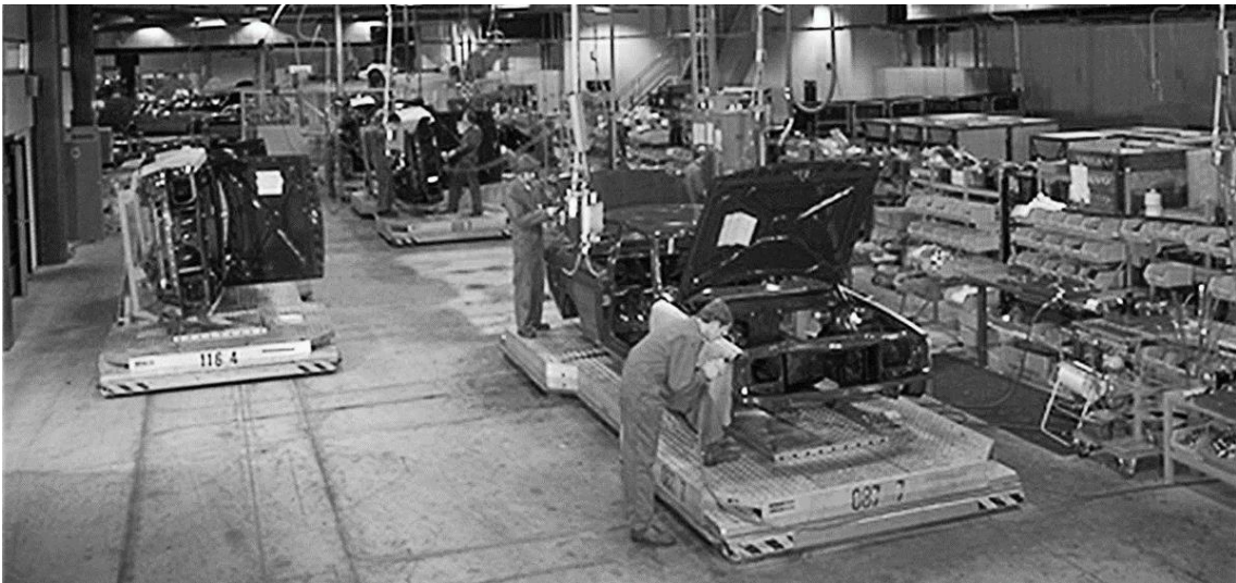
Şekil 2.2 Volvo'nun 1973 yılında geliştirdiği otomatik kılavuzlu araçlar (İnt. Kyn.9).
