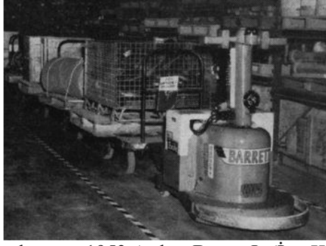
Şekil 2.1 İlk Otomatik kılavuzlu araç, 1953 Arthur Barret Jr (İnt. Kyn.8).
