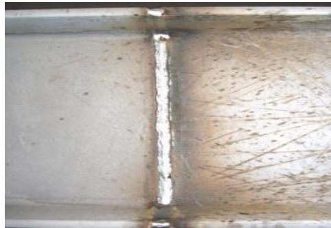
Resim 2.8 Küt kaynağın kiriş ekine uygulanması.
