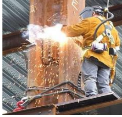
Resim 2.9 Küt kaynağın kolon ekine uygulanması.
