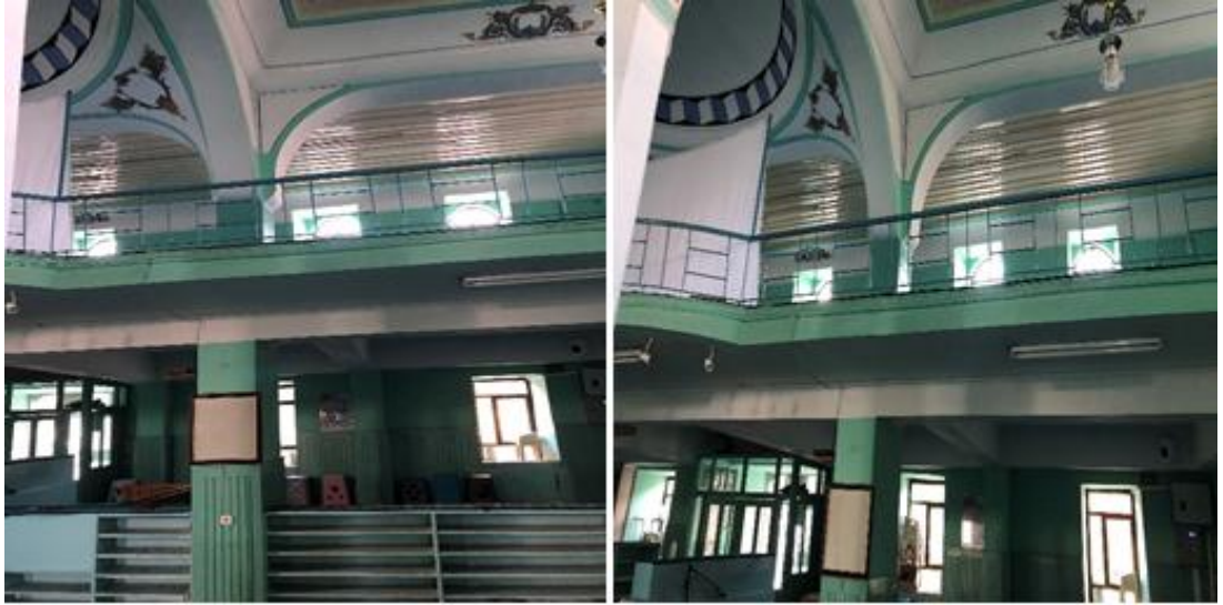
Resim 4.12 Betonarme kolon içerisinde kalan ahşap sütunlar.
