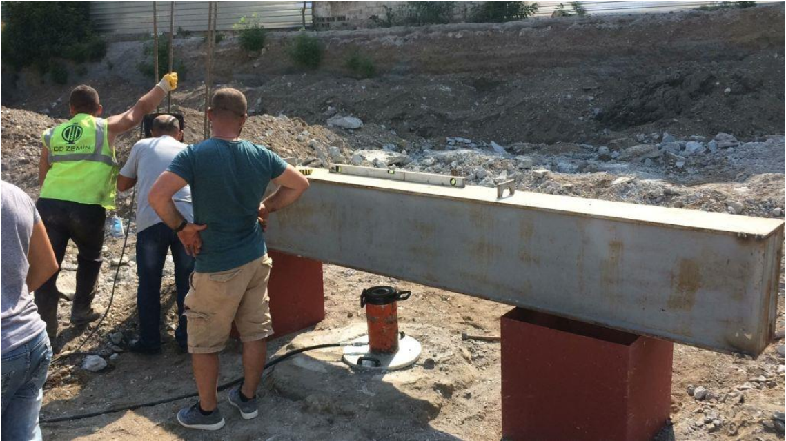
Resim 3.12 Test kazıklarına hidrolik krikolar ve saç plakaların yerleştirilmesi.
