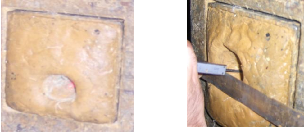
Resim 3.10 Arka kısım dolgu malzemesinde meydana gelen deformasyon.
