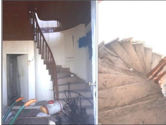
Şekil 47. Veysel Seyis Evi Ahşap Dönerli Merdiven
