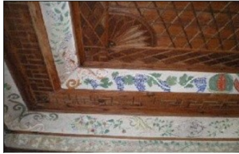
Şekil 24. Kalem İşi Tekniđiyle Yapılmış Bir Tavan Örneđi
