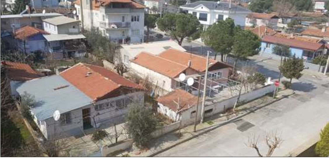
Şekil 20. Merkezefendi İlçesinde Yer Alan Bahçelievler Mahallesi 'nde Bulunan Deprem Evlerinin Günümüzdeki Görünümü
