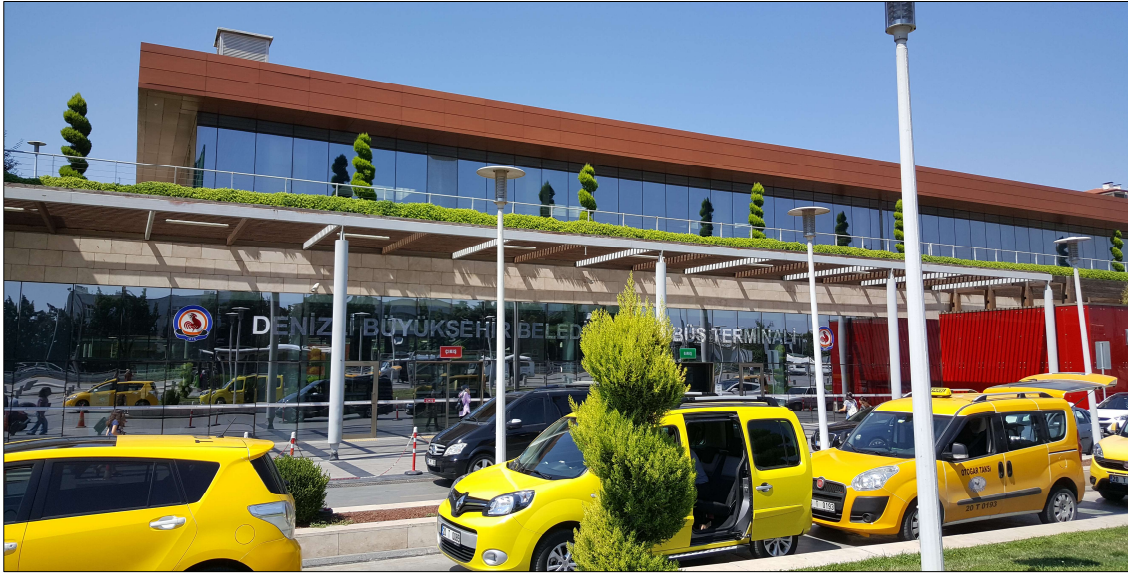
Şekil 182. 2014 Yılında Hizmete Giren Denizli Büyükşehir Belediyesi Otobüs Terminalinden Görünüm
