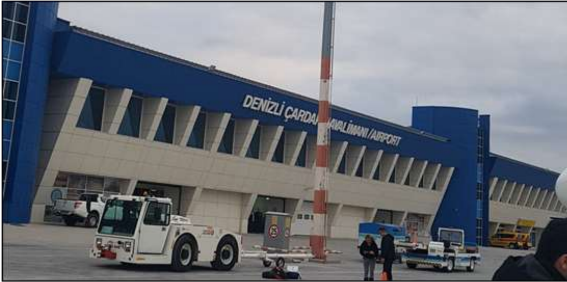
Şekil 134. Denizli İlinin Çardak İlçesinde Yer Alan Çardak Havalimanı'nın Apron Kısmından Görünüm
