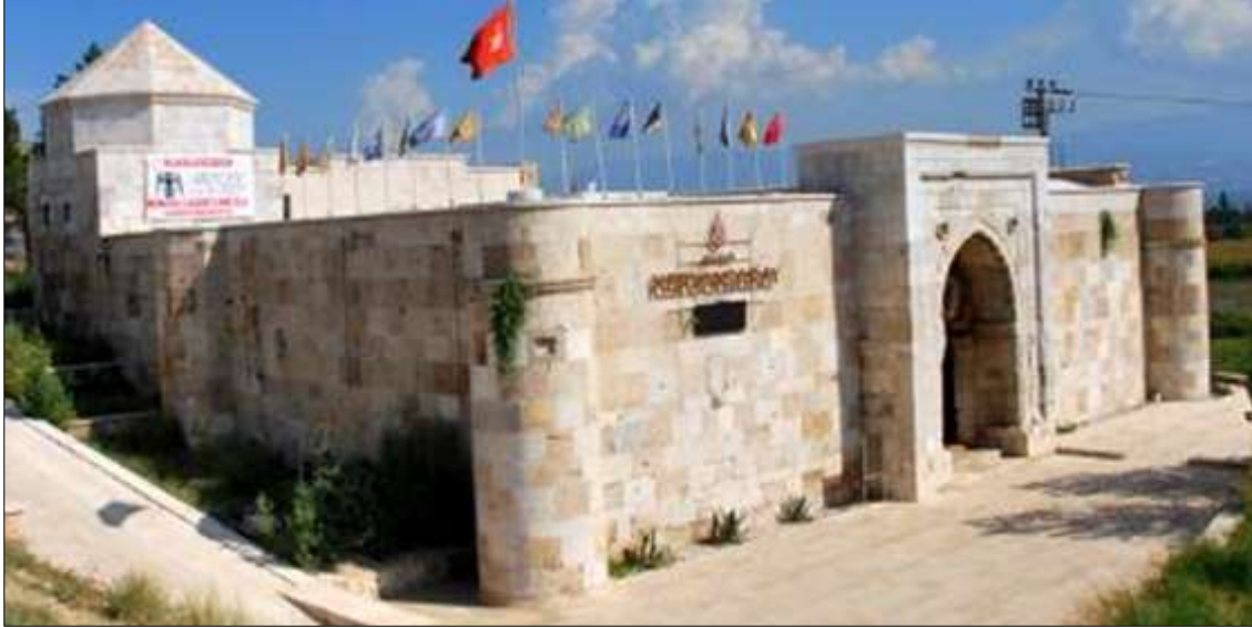
Şekil 70. Akhan Kervansarayının Taç Kapı Bölümünden Görünümü
