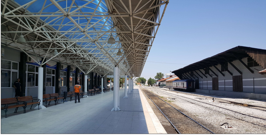
Şekil 183. Merkezefendi İlçesinde Sümer Mahallesi'nde Yer Alan Denizli Tren Garı 1889 Tarihinde Hizmete Girmiştir.
