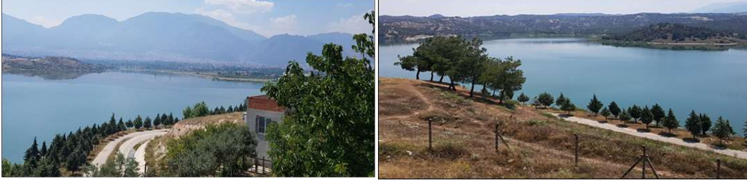
Şekil 45. Gökpinar Deresi Üzerine İnşa Edilen Vali Recep Yazıcıoğlu Barajı'ndan Görünüm
