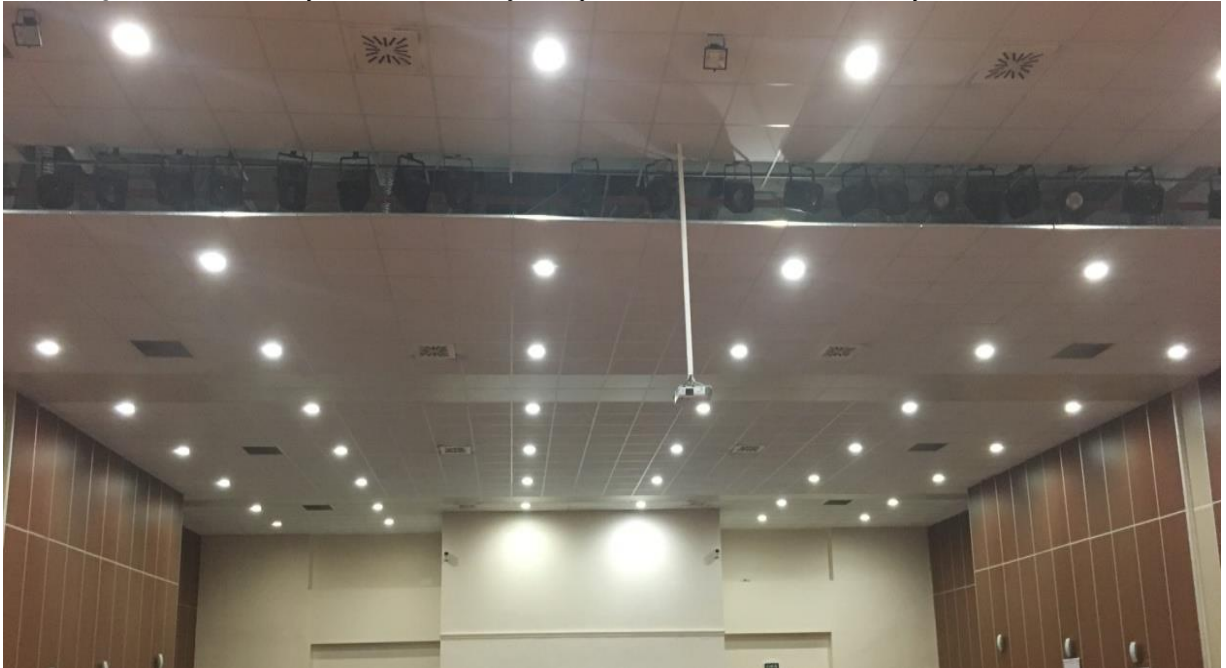
Şekil 69. Sahne Aydınlatmasında Işık Köprüsü ve Fresnel Merceкли Aydınlatma
