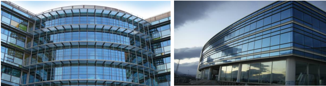
Şekil 19. Giydirme Cepheler-Transparan Giydirme Cephe Örnekleri
