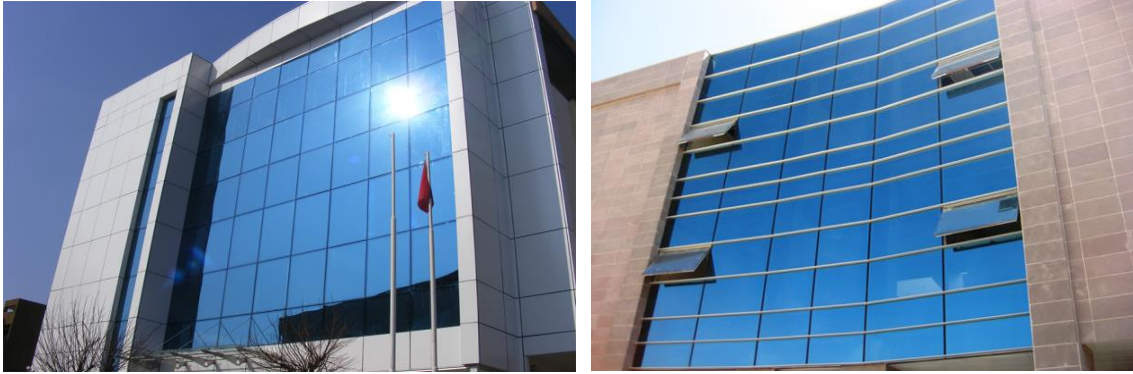
Şekil 20. Giydirme Cepheler-Silikon Giydirme Cephe Örnekleri
