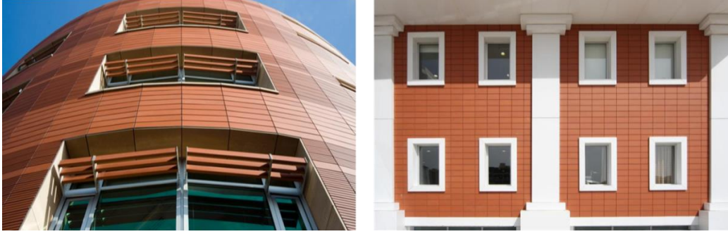
Şekil 13. Terra Cotta Kaplama Örnekleri
