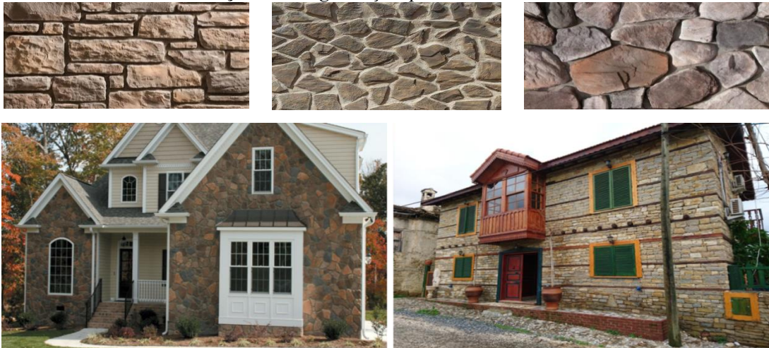
Şekil 7. Doğal Taş Kaplama Örnekleri
