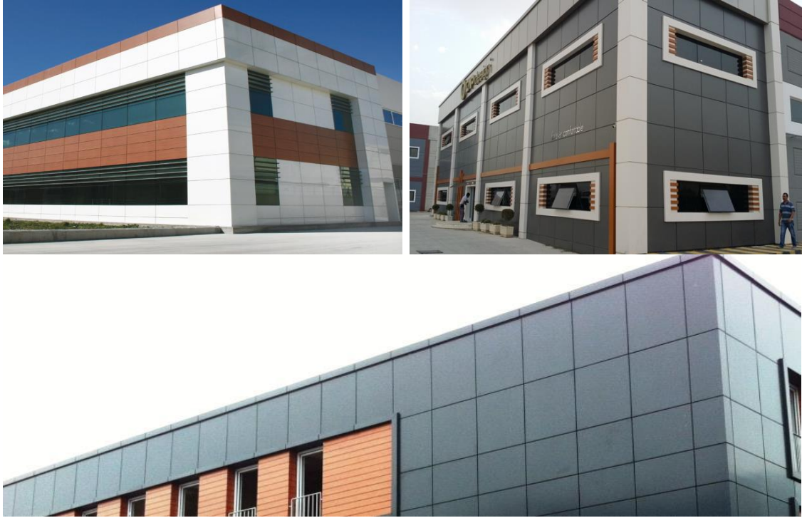
Şekil 21. Giydirme Cepheleer-Kompozit Panel Kaplama Örnekleri
