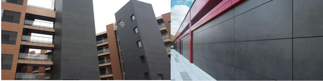
Şekil 12. Seramik Kaplama Örnekleri
