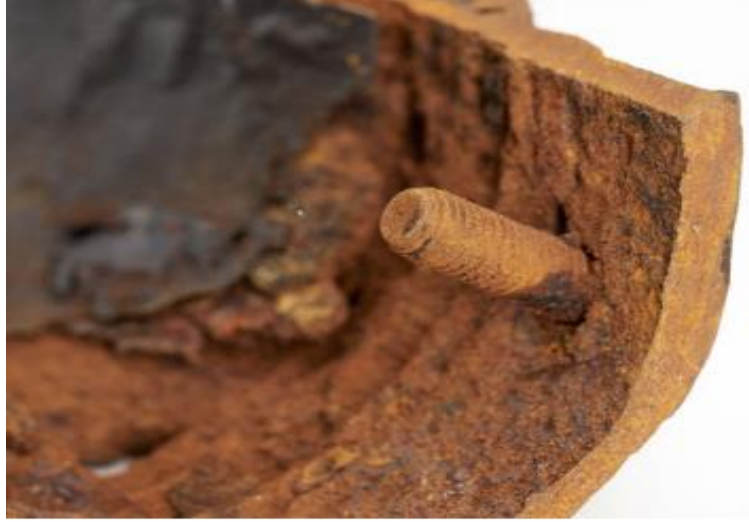
Resim 2.1 Politecnico di Milano Polilapp Korozyon Müzesi'nde galvanik korozyon vaka çalışması.
